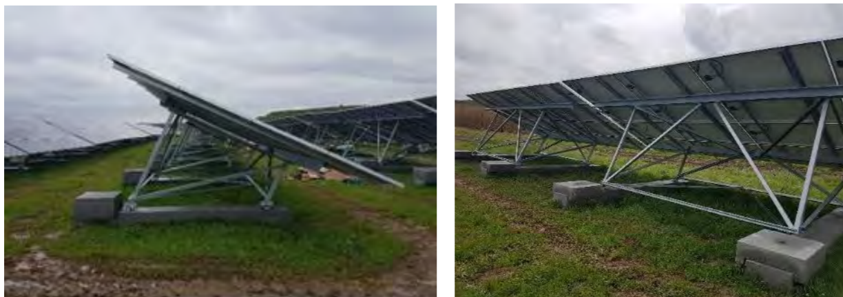
Exemple de fondations béton – Q ENERGY France
